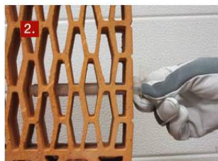
2. Установить в просверленное отверстие соответствующую сетчатую гильзу.
