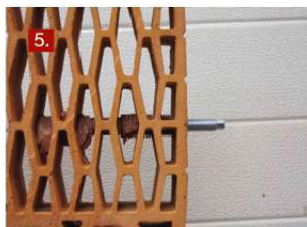
5. В период схватывания химического состава положение анкера можно корректировать.
