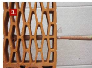
3. Равномерно заполнить весь объем сетчатой гильзы химическим составом.
